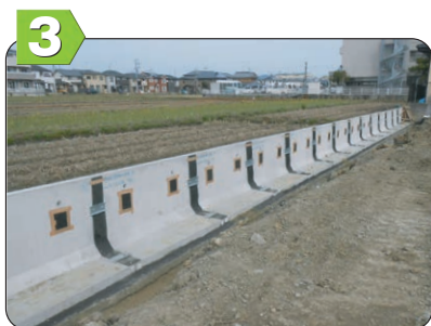
据付け 土粒子止めフィルター設置
