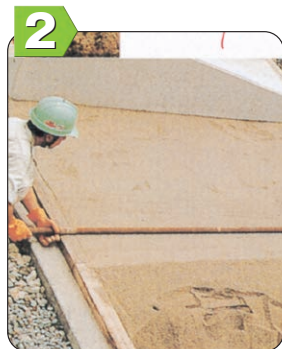
敷モルタルの施工
